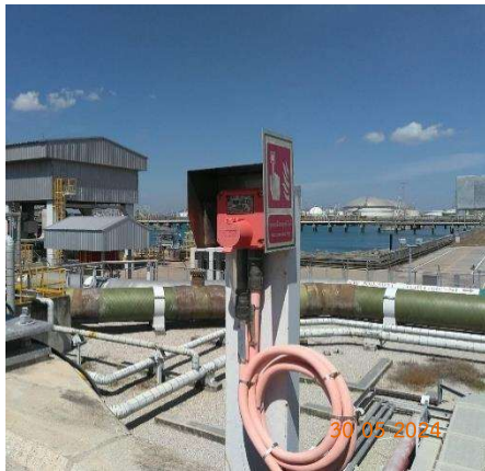
อุปกรณ์แจ้งเหตุฉุกเฉิน (Manual Call Point) บริเวณท่าเทียบเรือ
