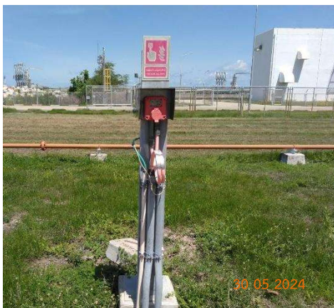
อุปกรณ์แจ้งเหตุฉุกเฉิน (Manual Call Point) ภายในพื้นที่โครงการ
