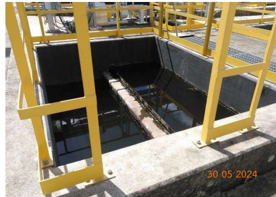
รูปที่ 1-11 ระบบ CPI Separator
